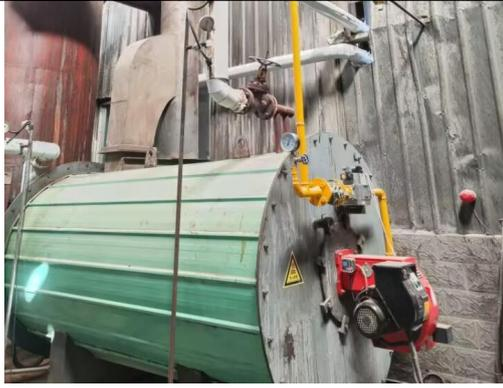
0.5MW 有机热载体炉
