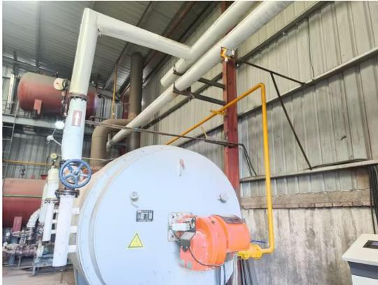
1.4MW 有机热载体炉
