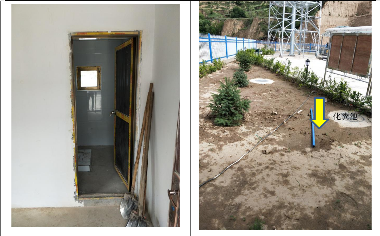
图 4-6 公厕及化粪池
