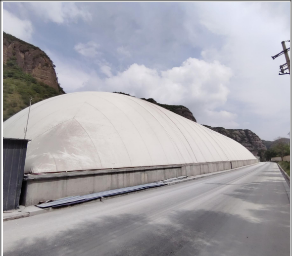
全封闭气膜式石灰成品库
