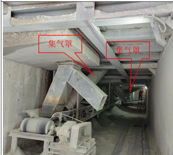
石灰窑出灰廊道+集气罩
